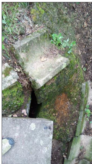
Odpadnutý skluz u křídla OP2 vpravo_2.jpg
