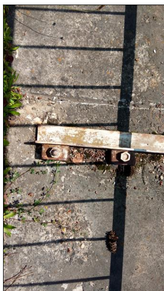
Uchycení ochranné plošiny vlevo.jpg
