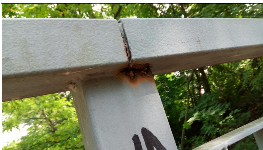
koroze zábradlí vpravo.jpg
