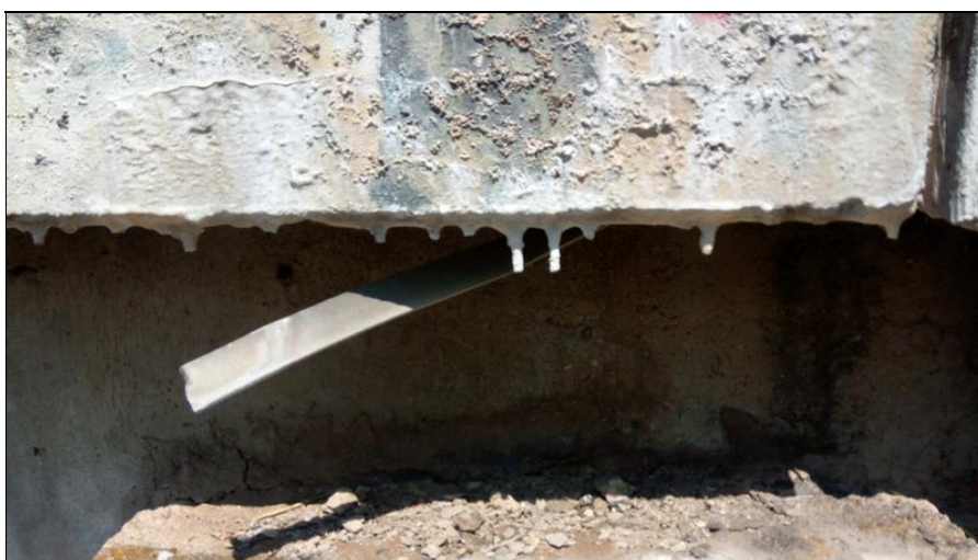
Stalagtitý na římsě vlevo.jpg
