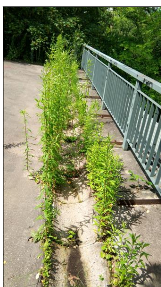
Uchycení vegetace u římsy vpravo_2.jpg
