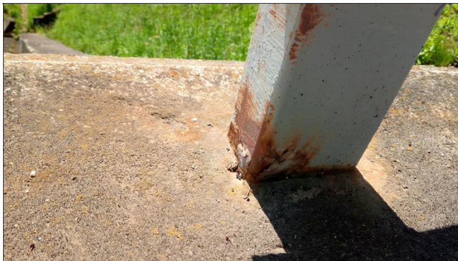
Koroze sloupku zábradlí vlevo.jpg
