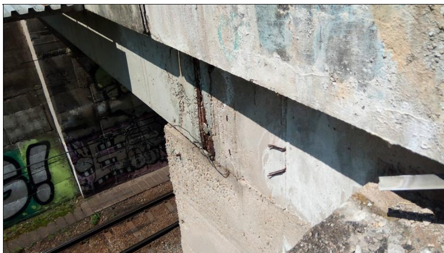
Odpadnutý beton u křídla OP2 vpravo.jpg
