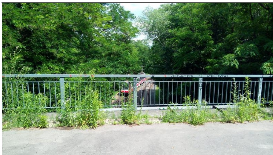
Uchycení vegetace u římsy vpravo_2.jpg
