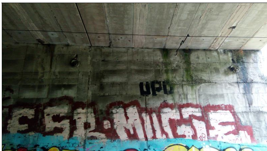
OP2 pravá část - stopy po zatékání u krajního pole.jpg
