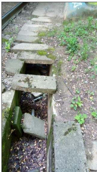
Rozbité krycí dlaždice odvodnění kolejíště.jpg
