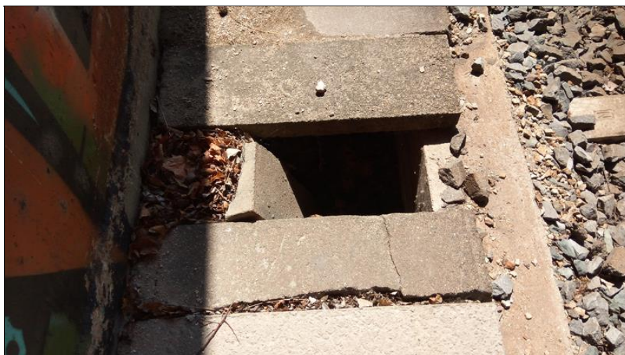
Rozbitá krycí dlaždice odvodnění kolejí.jpg
